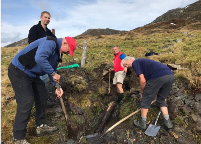
Ausheben des Erdreichs mit- samt der alten Quelfassung
